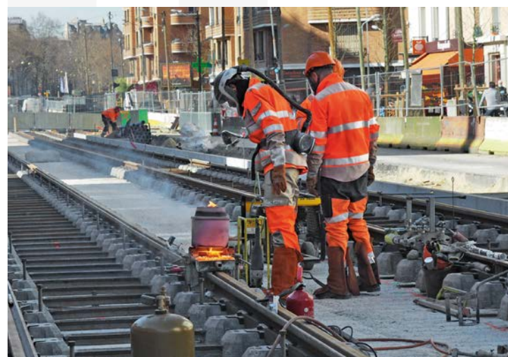
Chantier de prolongement du T3b.
