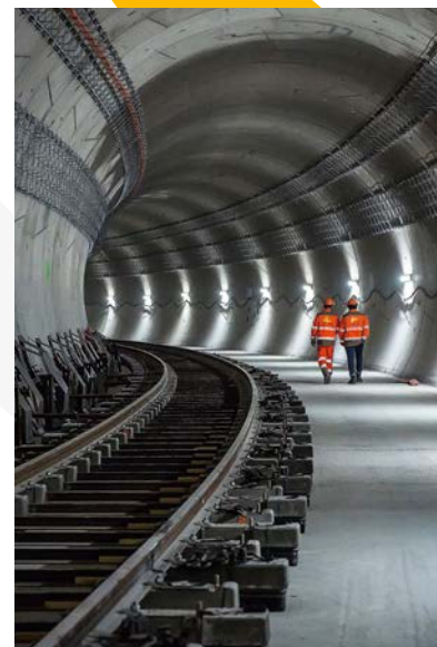
Travaux de prolongement de la ligne 14.
