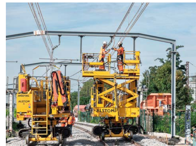
Remplacement des ponts de Chartres et Gallardon.
