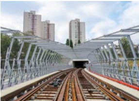
Station Coteaux Beaclair, ligne 11 Ligne 11 : à la station Télégraphe, recourir à du petit outillage et à des méthodes dites « traditionnelles » pour creuser l'extension par tranches de 80 centimètres chaque jour, afin de s'adapter aux contraintes du terrain.
