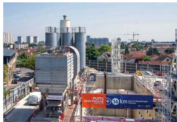
Puits de lancement d'un tunnelier à L'Haj-les-Roses sur le chantier du prolongement de la ligne 14 sud.
