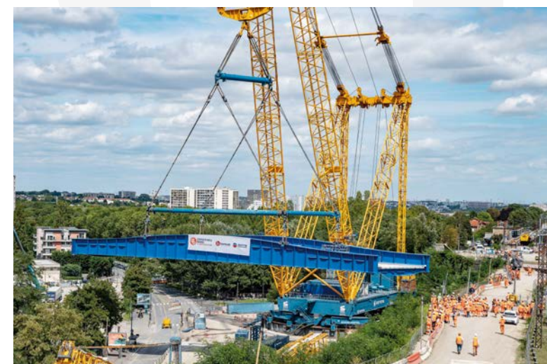
Chantier de renouvellement des ponts de Chartres et de Gallardon mené par SNCF Réseau et la RATP pour améliorer la performance des RER B et C.
