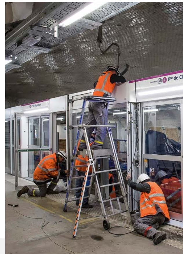
Montage des portes palières sur la ligne 4.
