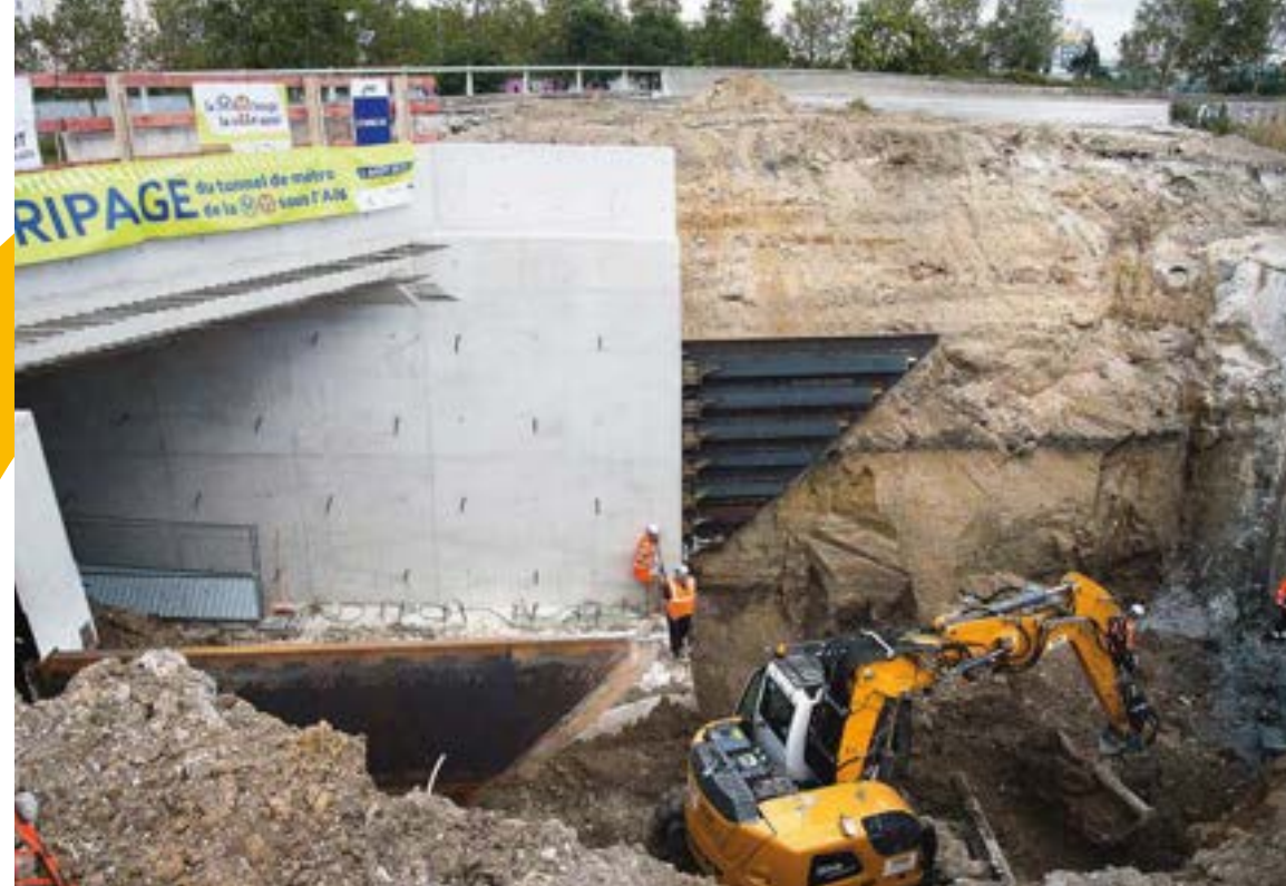
Opération de ripage du tunnel de métro de la ligne 11 sous l'autoroute A86.
