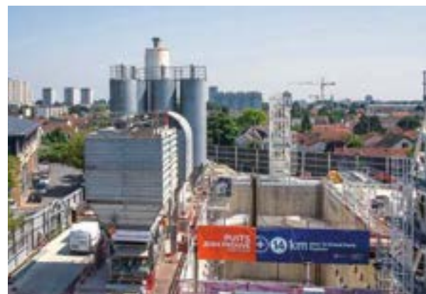
Puits de lancement d'un tunnelier à L'Hajj-les-Roses sur le chantier du prolongement de la ligne 14 sud.
