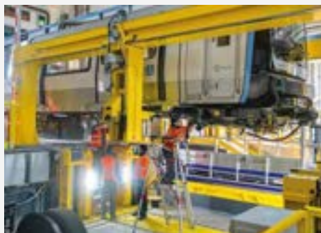
Atelier de maintenance des trains (AMT) de la ligne 11 à Rosny-sous-Bois.
