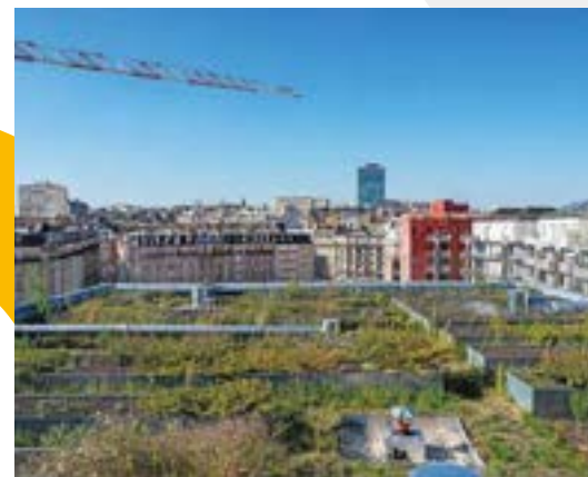
Toits végétalisés aux Ateliers Vaugirard.
