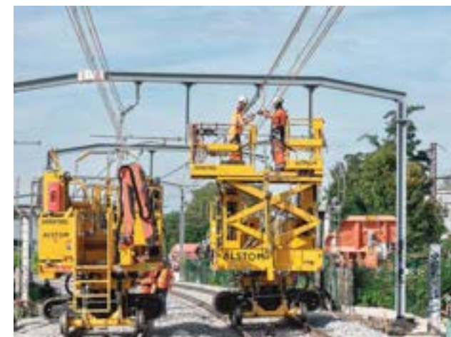
Remplacement des ponts de Chartres et Gallardon.
