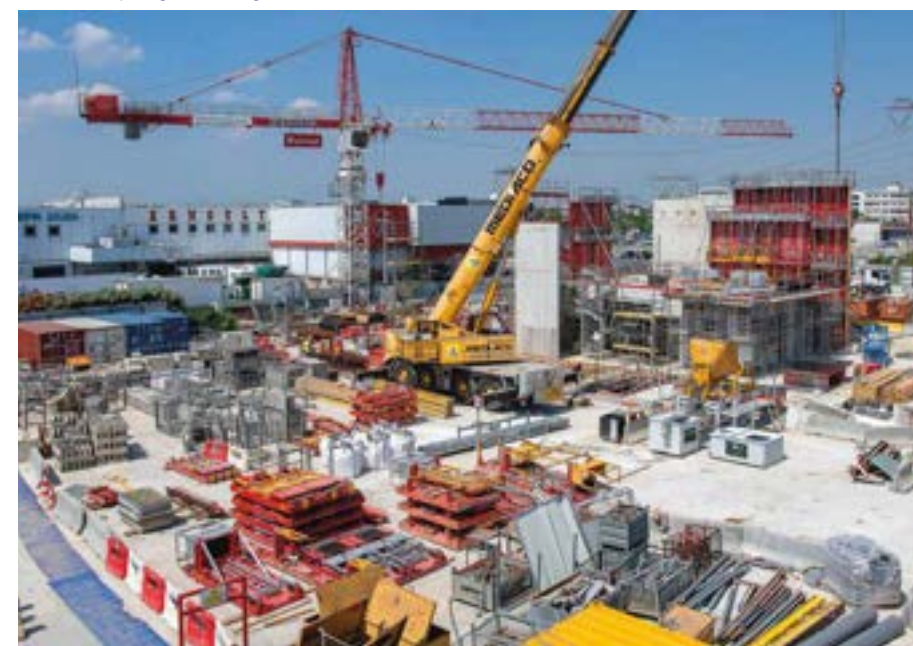
Chantier du prolongement de la ligne 14 au sud.
