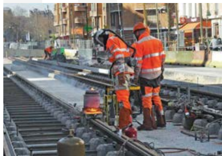
Chantier de prolongement du T3b.
