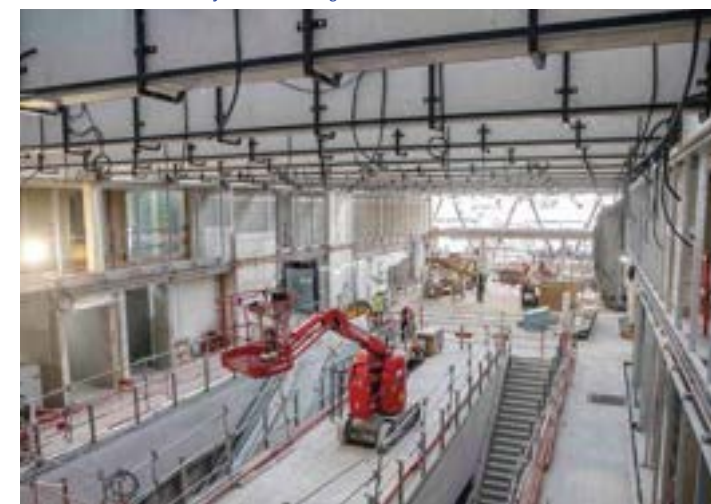
Construction de la station L'Haj-les-Roses sur la ligne 14.
