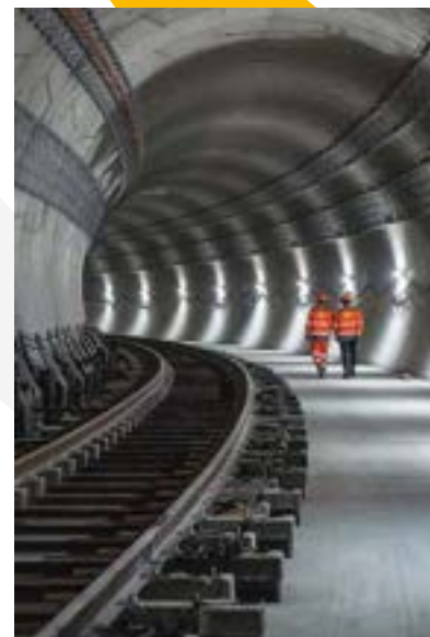
Travaux de prolongement de la ligne 14.
